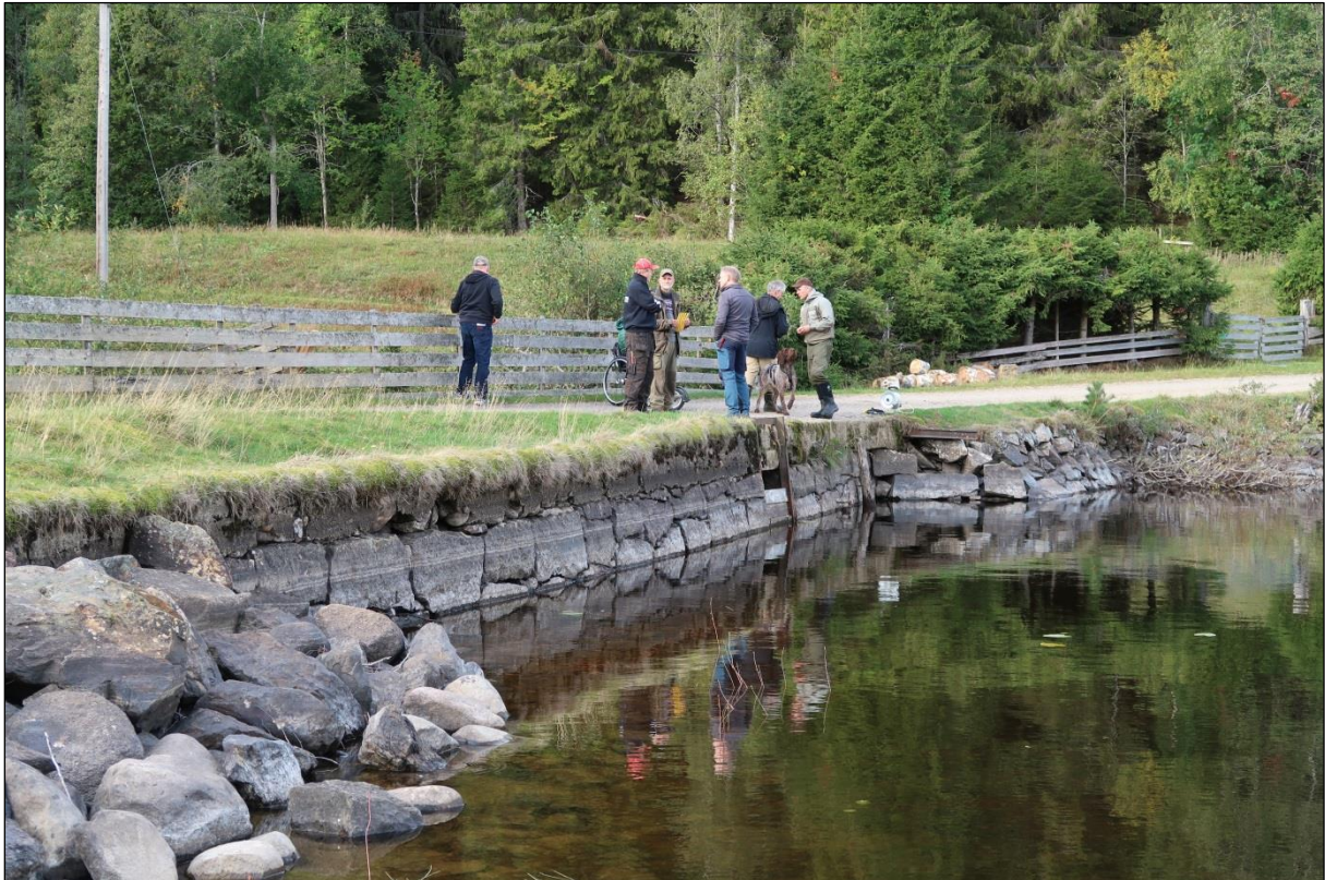
Fra befaringen av demningen i Lysjøen 14.9.18.
