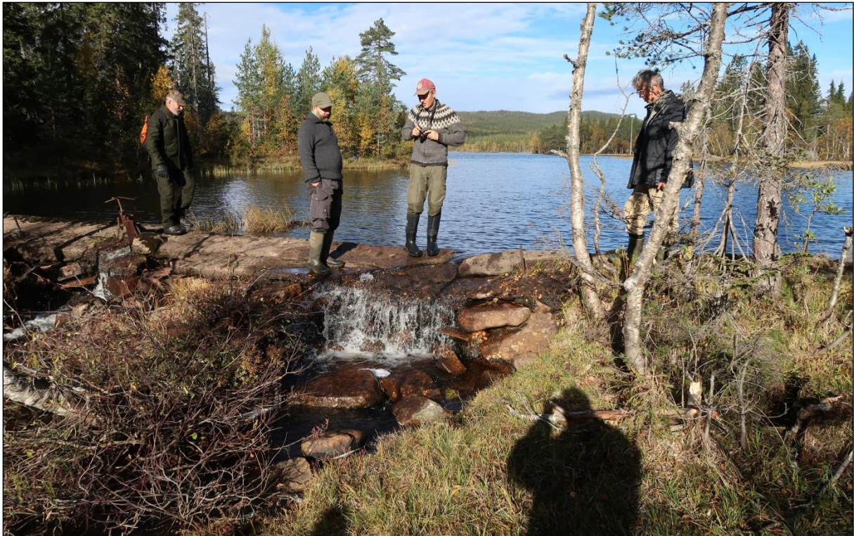
Fra befaringen av demningen av Store Vikka 1.10.18.
