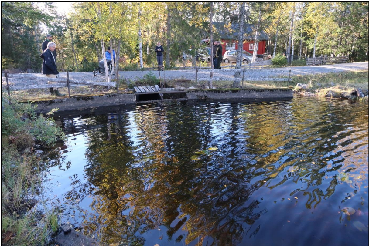
Fra befaringsen av demningen av Honsjøen 1.10.18.
