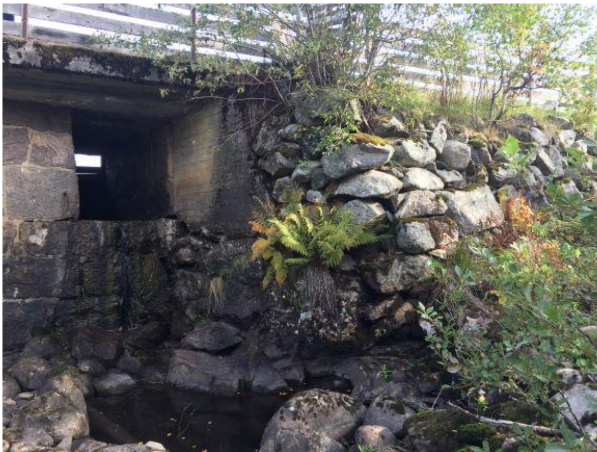
Steinsatt dam nedstrøms på østsiden.
