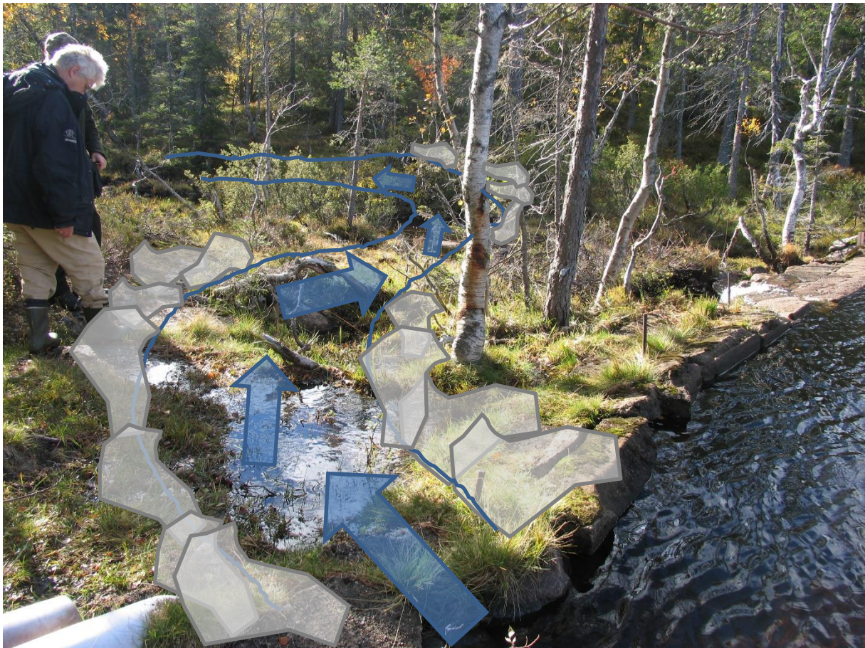
Figur 6. Mulig plassering av nytt bekkeløp på østsiden av demningen. En eksisterende lekkasje i demningen viser hvor vannet vil følge terrenget (se piler). Mellom det nye bekkeløpet og demningen bør det sikres mot erosjon ved at større blokker boltes fast til fjellet med armeringsjern og videre festes til demningen vha. betong (se plassering av stein i inner- og yttersvinger skissert på bildet). Foto: Odin Kirkemoen.
