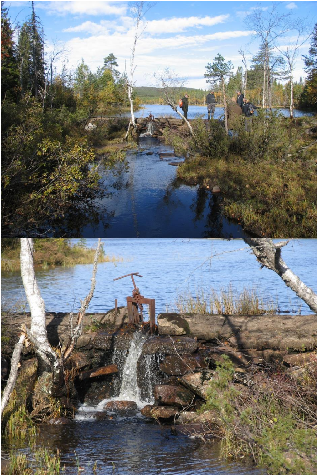
Figur 10. Over: demningen sett fra sørsiden. Under: damluka sett fra sørsiden. Foto: Odin Kirkemoen.
