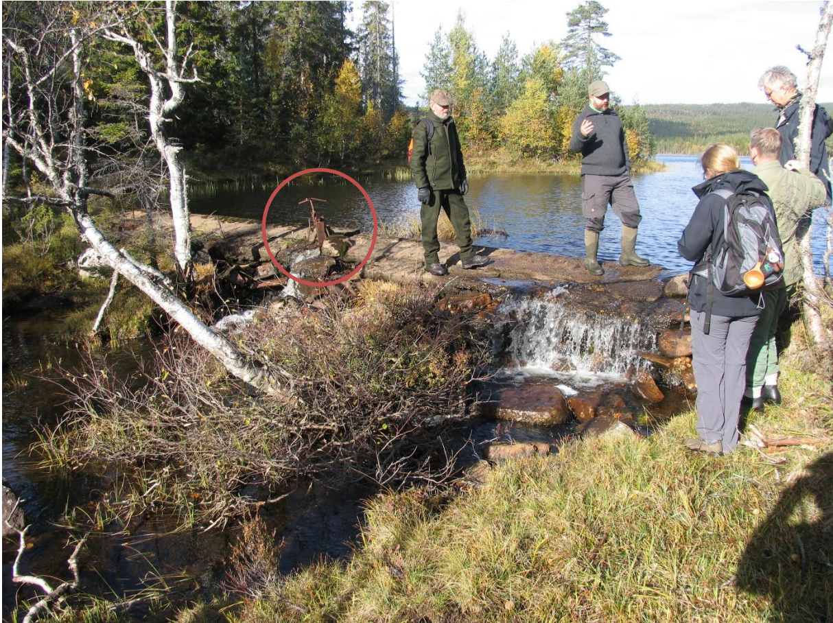
Figur 3. Vandringshinderet i Store Vikka. Damluka vises i rød sirkel i midten av bildet. Dammen har flere lekkasjer, hovedsakelig på østsiden av demningen, slik bildet viser til høyre. Foto: Odin Kirkemoen.
