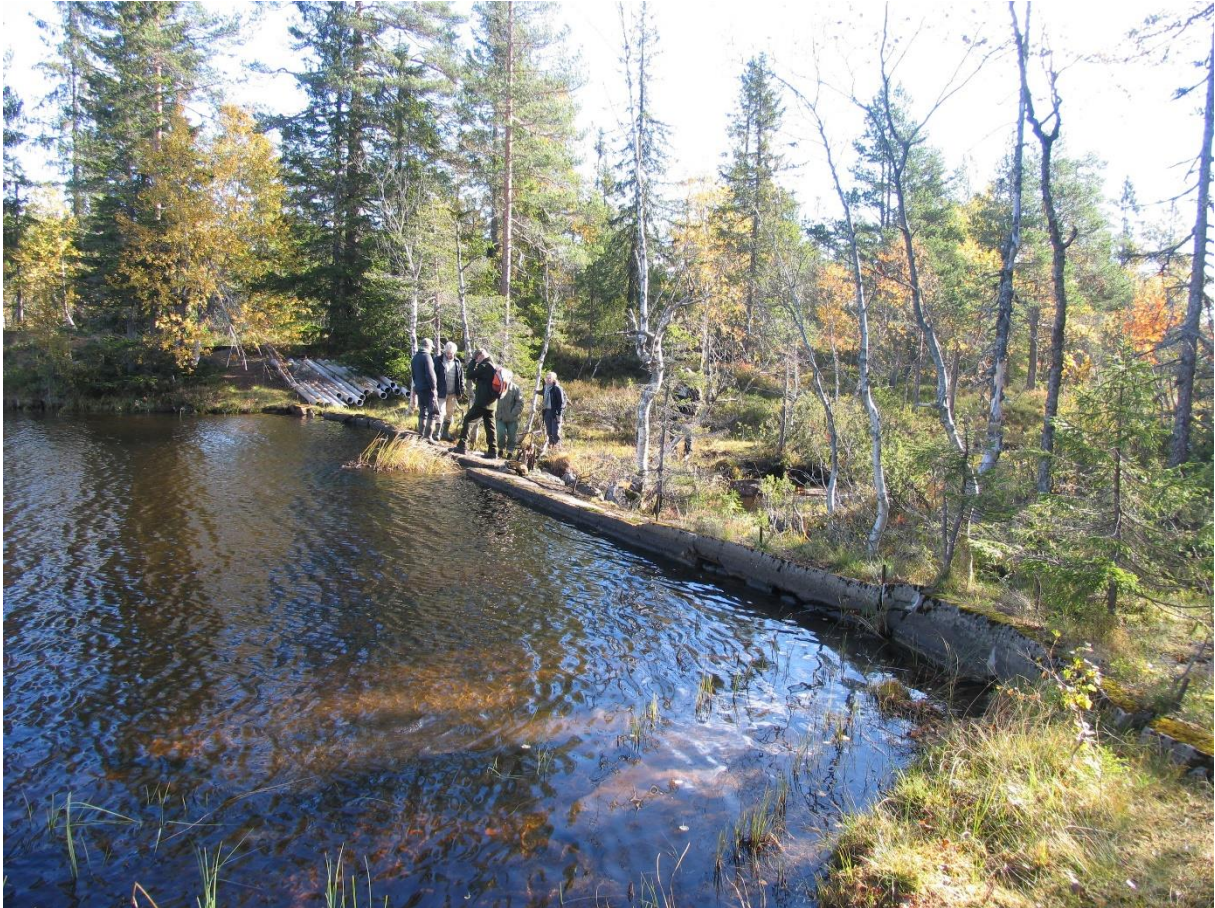
Figur 2. Demningen ved Store Vikka fotografert fra vest. Demningen består av en steinkropp med en damkrone av betong. Totalt er demningen ca. 0,8 m høy på det høyeste og 12 m lang. Bildet viser også plastrørene på østsiden av demningen, som ønskes transportert ut av området. Foto: Odin Kirkemoen.
