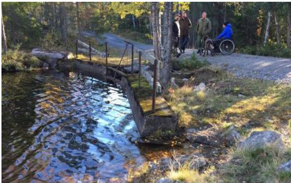
Honsjødammen sett mot øst.
