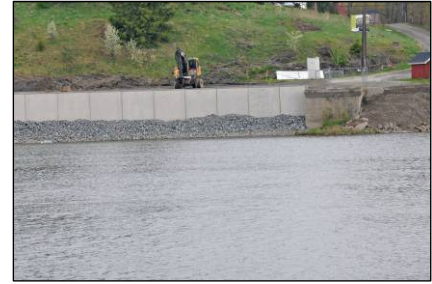
Som en følge av sterk befolkningsvekst, forventes økt press på vassdragenes kantsoner.
