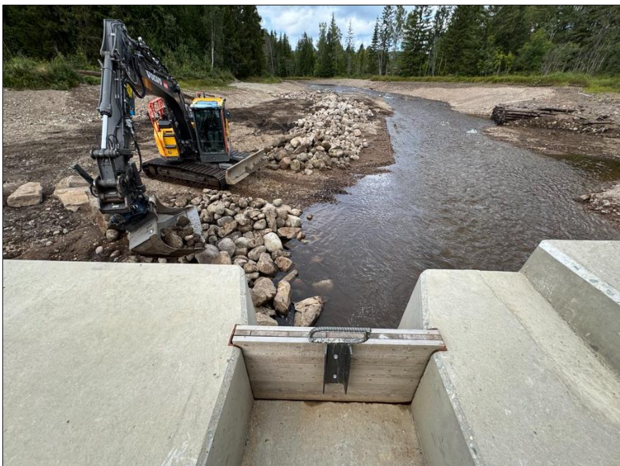
Foto 6. Steingjerdet/ledegjerdet etableres, for å gi nedvandrende ungfisk skjul og lede dem direkte til fiskeavlederen. Fiskeavlederen i midten av bildet, med nålestengsel for å kunne regulere vannmengden etter behov/ønsker,
