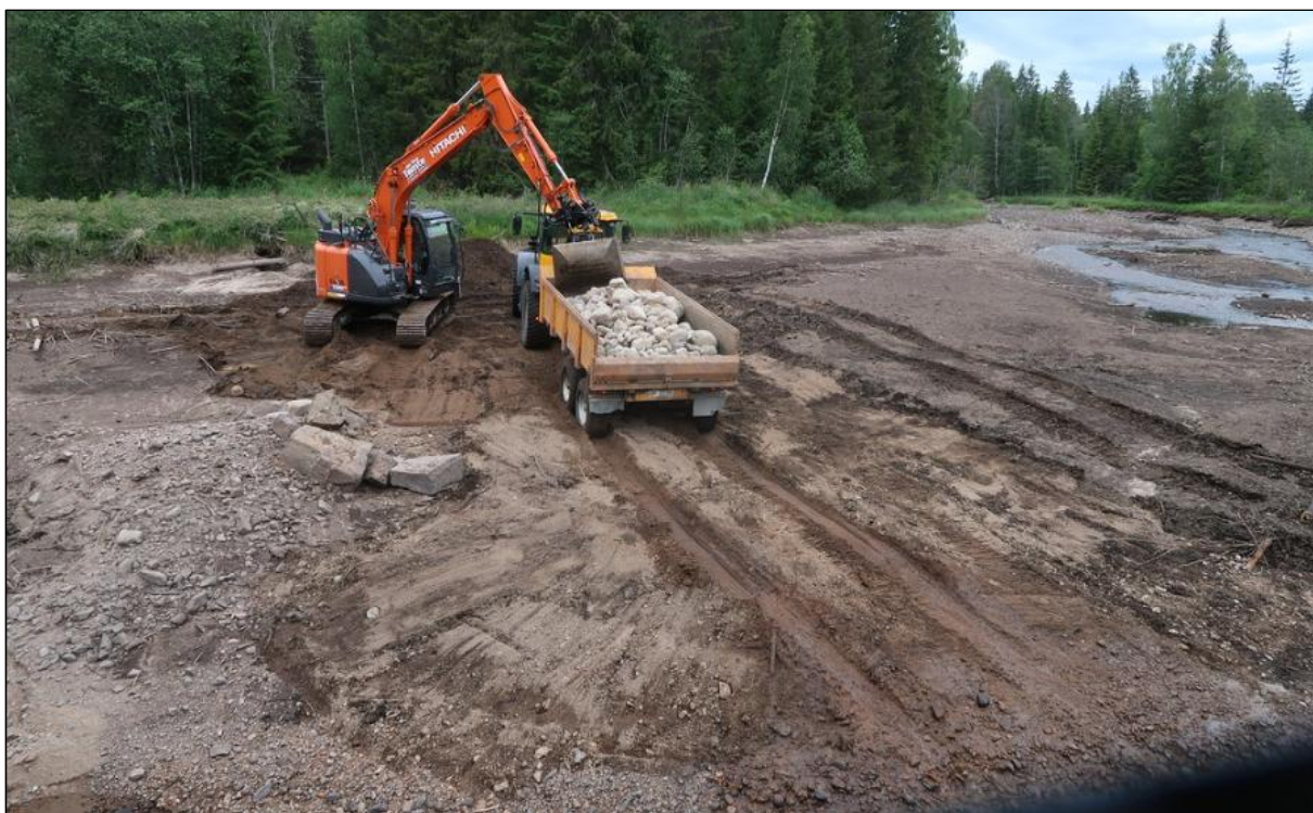
Foto 5. Tilkjøring av 200 – 240 tonn med stein, i fraksjon ca. 30 – 50 cm. For å etablere skjul/steingjerde/ «ledegjerde» for ungfisk på vei ned elva og ut i Hurdalssjøen.
