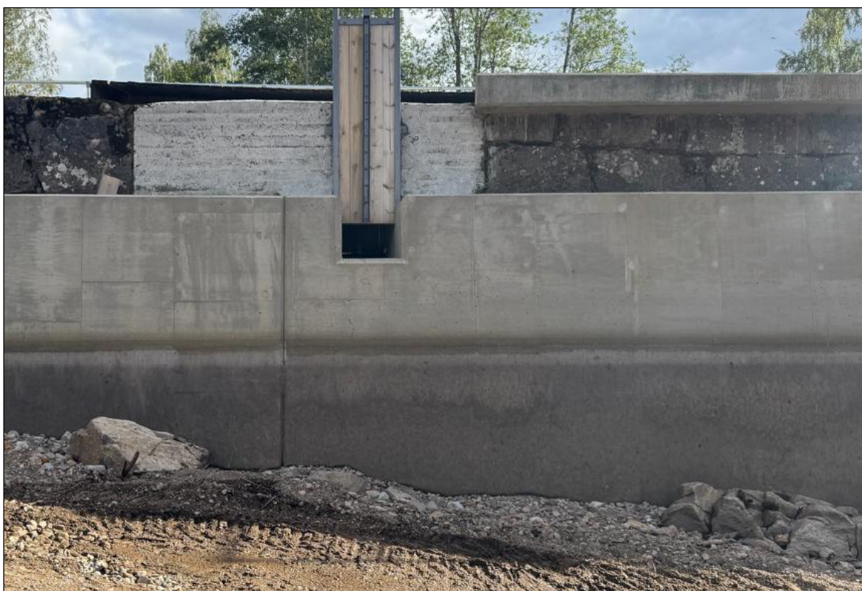
Foto 4. Innfasing/klargjøring for øvre trinn i fisketrappa. Med nålestengsel for aktiv regulering /styring av vannmengde.
