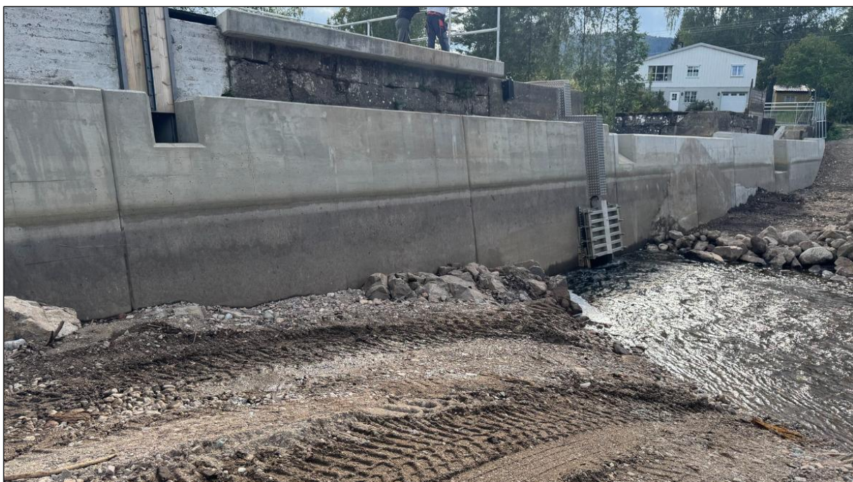
Foto 3. Støpingen/forsterkingen av demningen oppstrøms, med nedsparring av luke til fisketrappa (tv.) og fiskeavleder for nedvandring (omtrent i midten av bildet).
