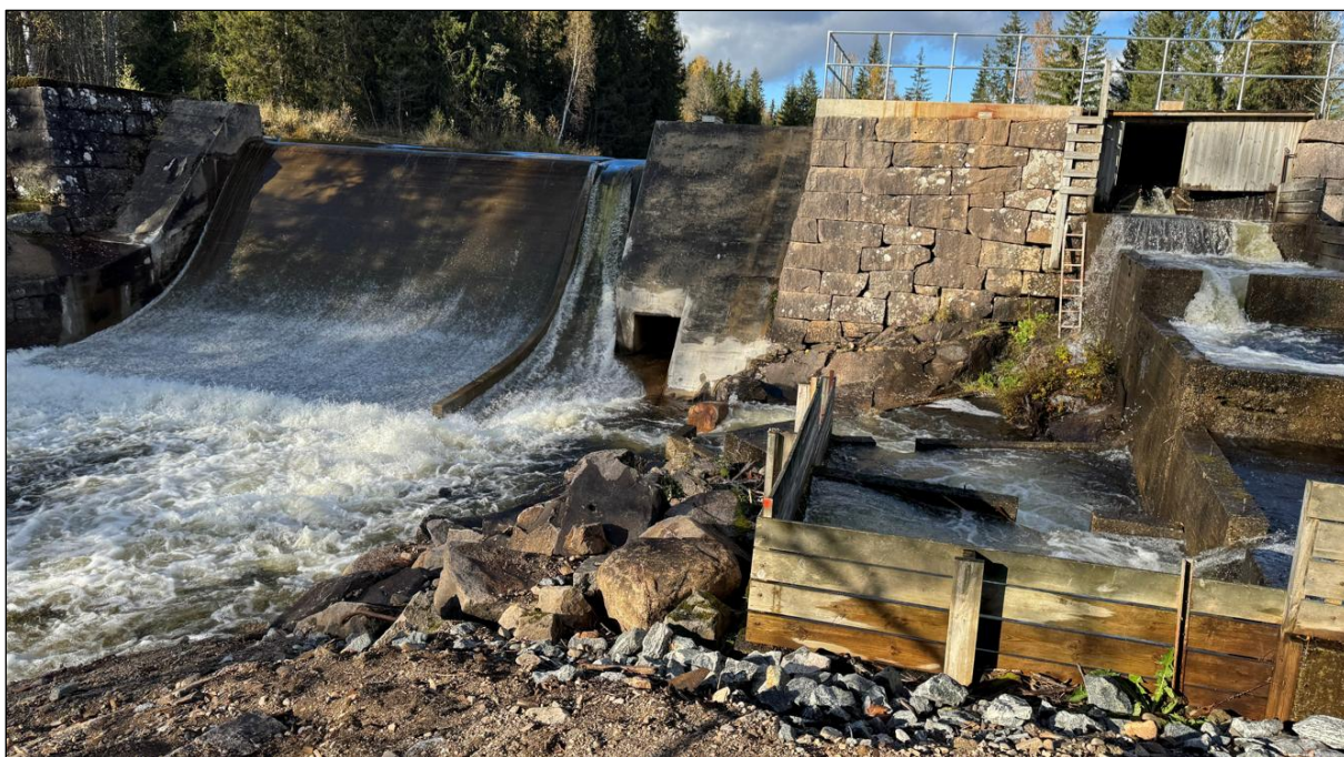
Foto 9. Ferdig fornyet demning, med vann både i fisketrappa og fiskenedløpet (selv ved liten vannføring den 12.10.2026).
