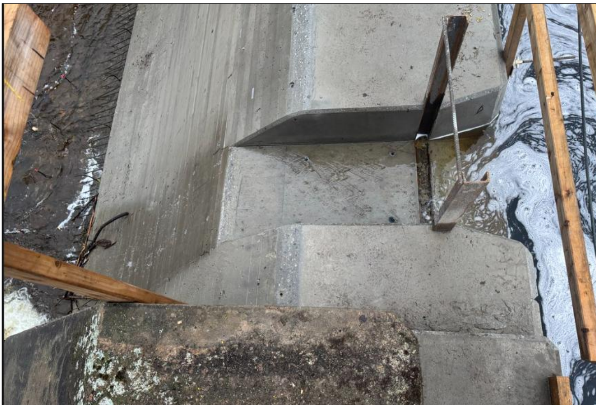
Foto 7. Bilde av fiskeavleiteren, der nålestengsel ble montert etter at bildet ble tatt.
