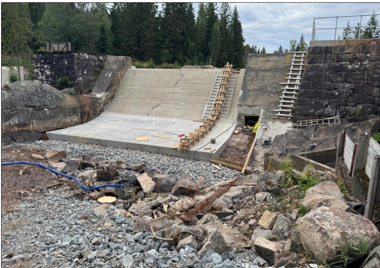
Foto 8. Støpingen av «fiskeskli». Et viktig poeng er at den skal munne ned i samme store kulp som inngangen til fisketrappa. (Kulpen ble senere utvidet/gravd så dyp/stor man fikk den).
