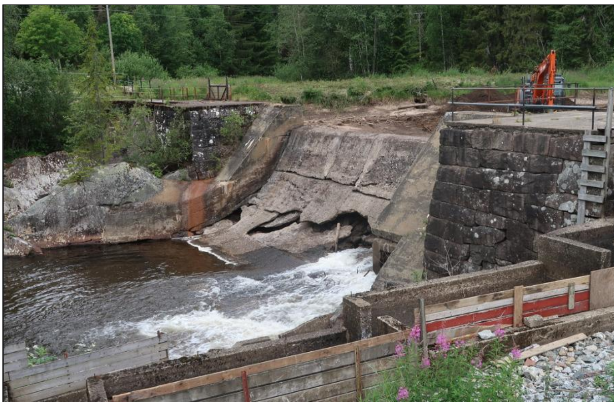
Foto 1. Demningen i Glassverkdammen før den ble restaurert.
