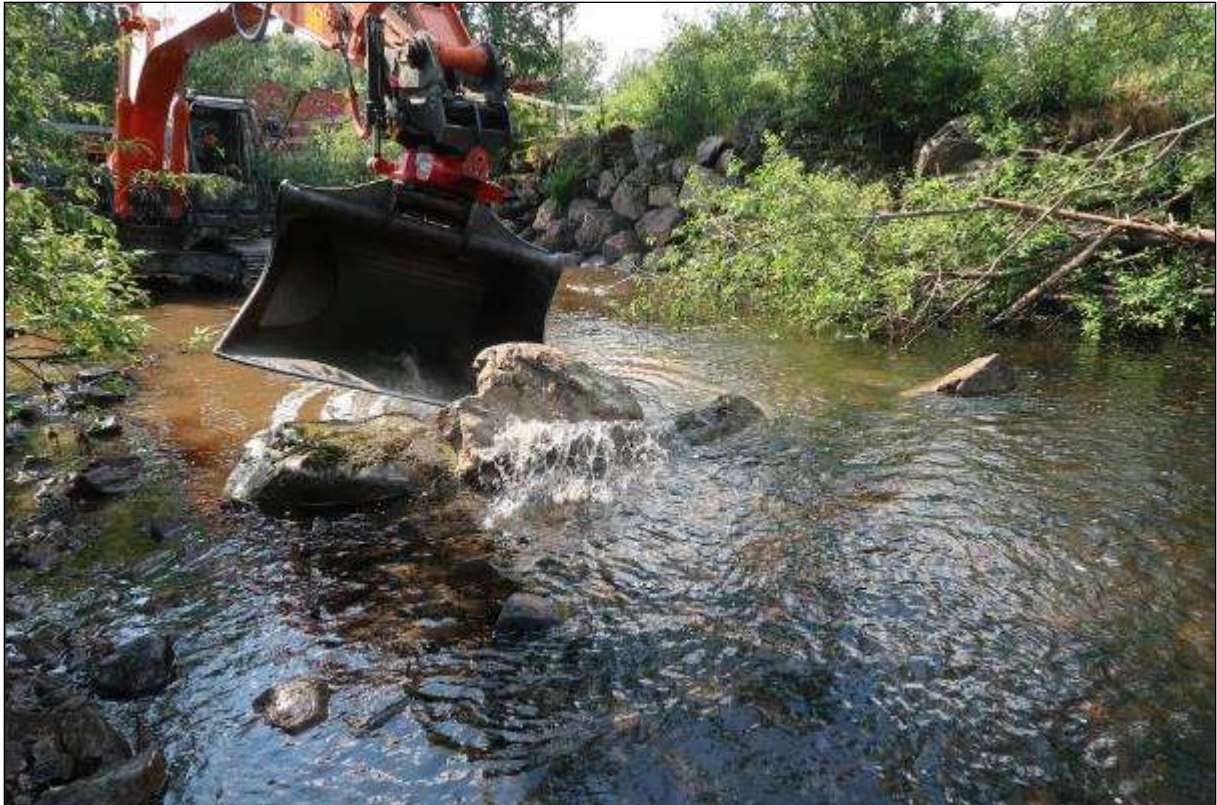
Foto 6. La ut store steinblokker i kulpene for å unngå at de fylles opp, og for å stabilisere elvebunnen og dempe vannets fart/energi under flomsituasjoner.
