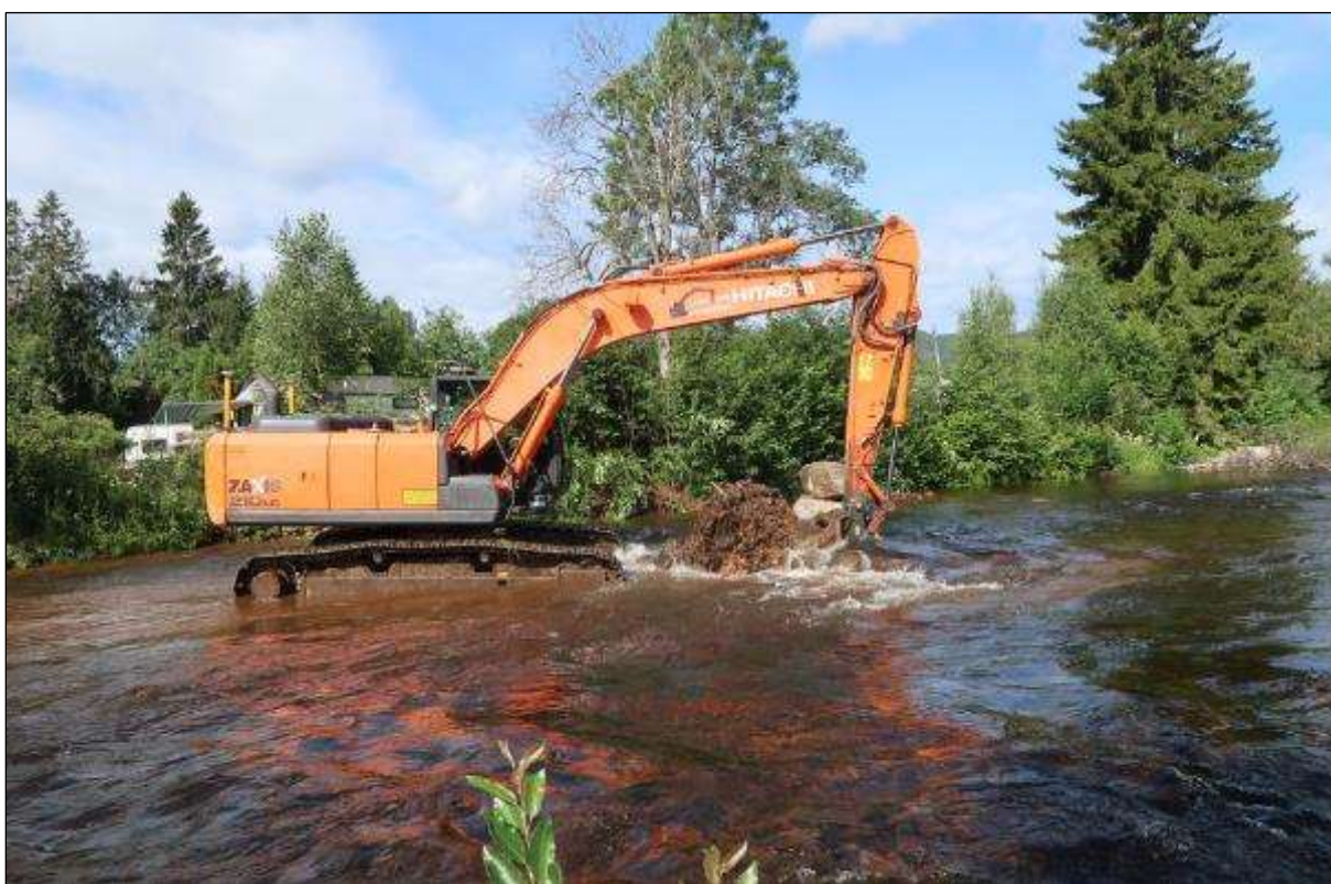
Foto 5. Grave opp og forsterket kulper. Dels med funksjon «hvilekulp» for oppvandrende storørret, dels refugier ved lav vannstand og dels som gyteplass.
