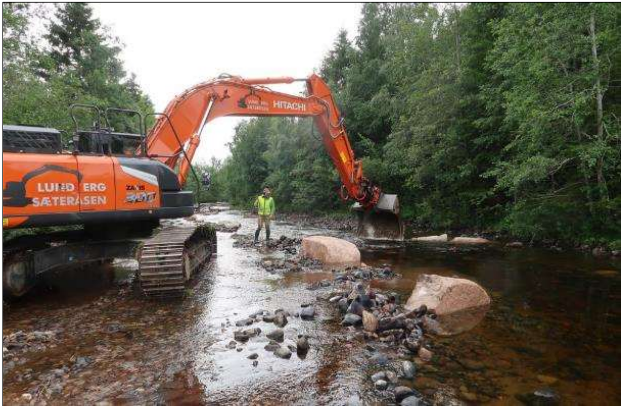
Foto 8. Etablerte/forsterket elvas djupål, i tråd med elvas «naturlige» løpsprofil, for å bedre fiskevandringen, og for å samle vannet ved lav vannføring.
