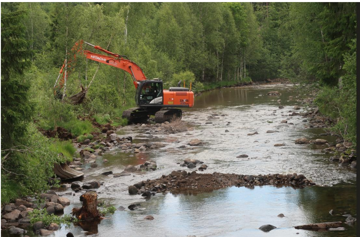
Foto 15. Den hydrauliske kapasiteten i elveløpet skulle ikke bli redusert som følge av restaureringen, slik at for hver kubikkmeter stein som ble tilført, ble tilsvarende mengde tatt ut av elvebunnen og plassert i nærheten på land.
