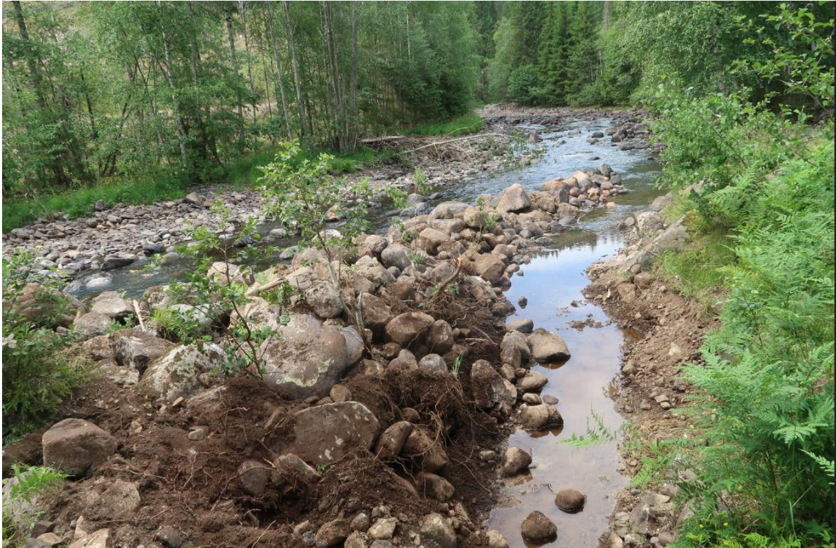
Foto 14. Sideløp ble gjenåpnet, for å lede/forsinke vann til egnet skogsområde ved kommende flomepisoder (klimatilpasningstiltak).
