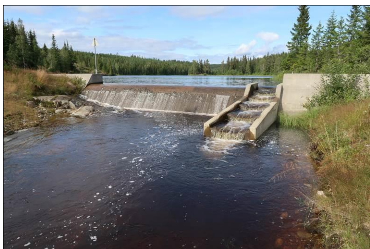
Figur 12. Bilde av demningen i Øvre Holsjø og fisketrappa.. Det ble fisket helt opp til trappa inkl. kulpene, og i trappene.
