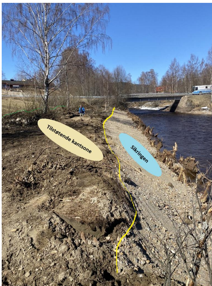
Figur 1 viser sikringen med rotstokker og tilstøtende kantsone. Gul linje markerer de to områdene og grønn linje viser uberørt gras areal. Personen på bildet er Helge B. Pedersen. Foto Anja C. Winger
