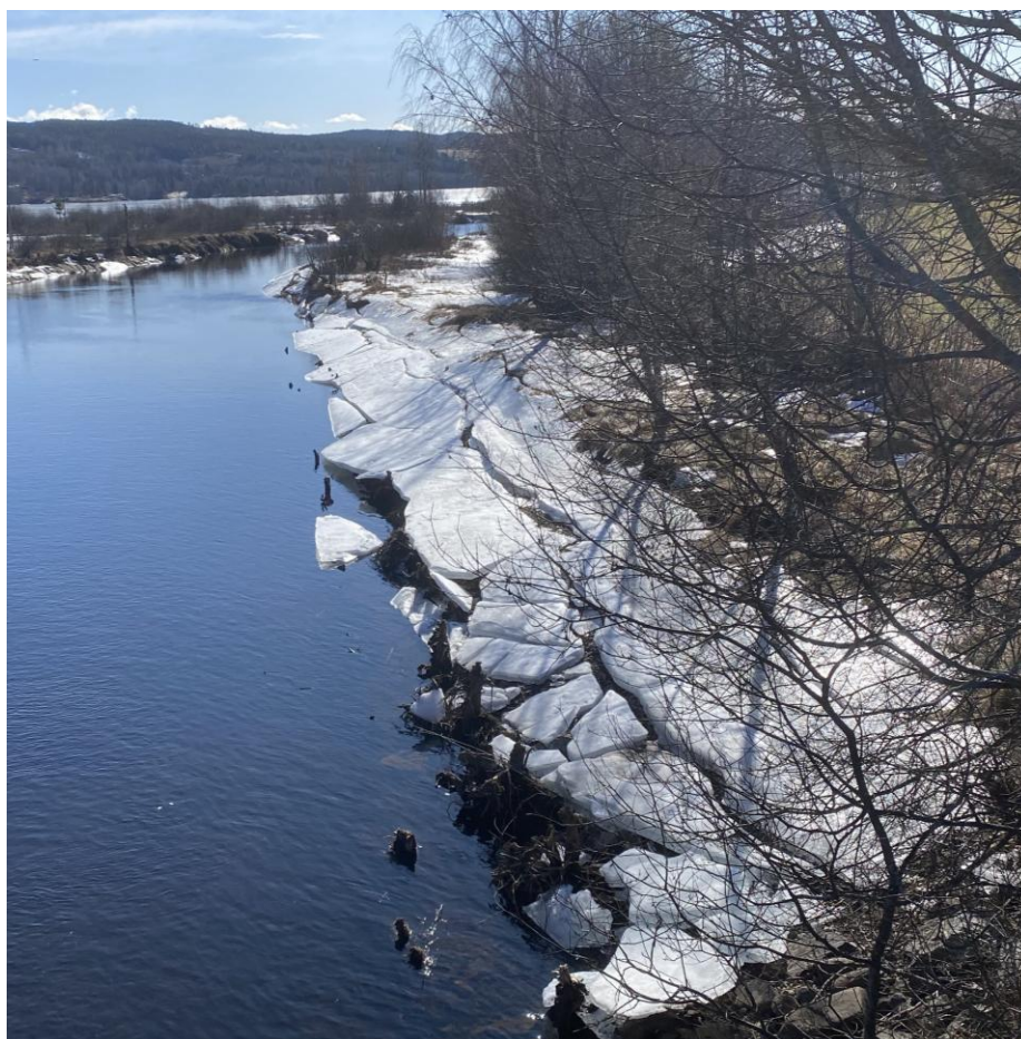
Figur 12 viser kanten 23. mars 2026. På bilde ser en tydelig det tykke islaget som legger seg over fyllingen etter som vannstanden synker gjennom vinteren (Foto: Anja C. Winger)
