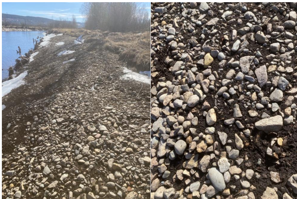
Figur 9 viser gruslaget som beskytter jordmasser og rotstokker i sikringen samt overgangen mellom sikringen og tilstøtende kantsone. Til høyre ser vi et nærbilde av det fine laget med jordpartikler som har lagt seg på grusen, bildet er fra 2025 (Foto Anja C. Winger)
