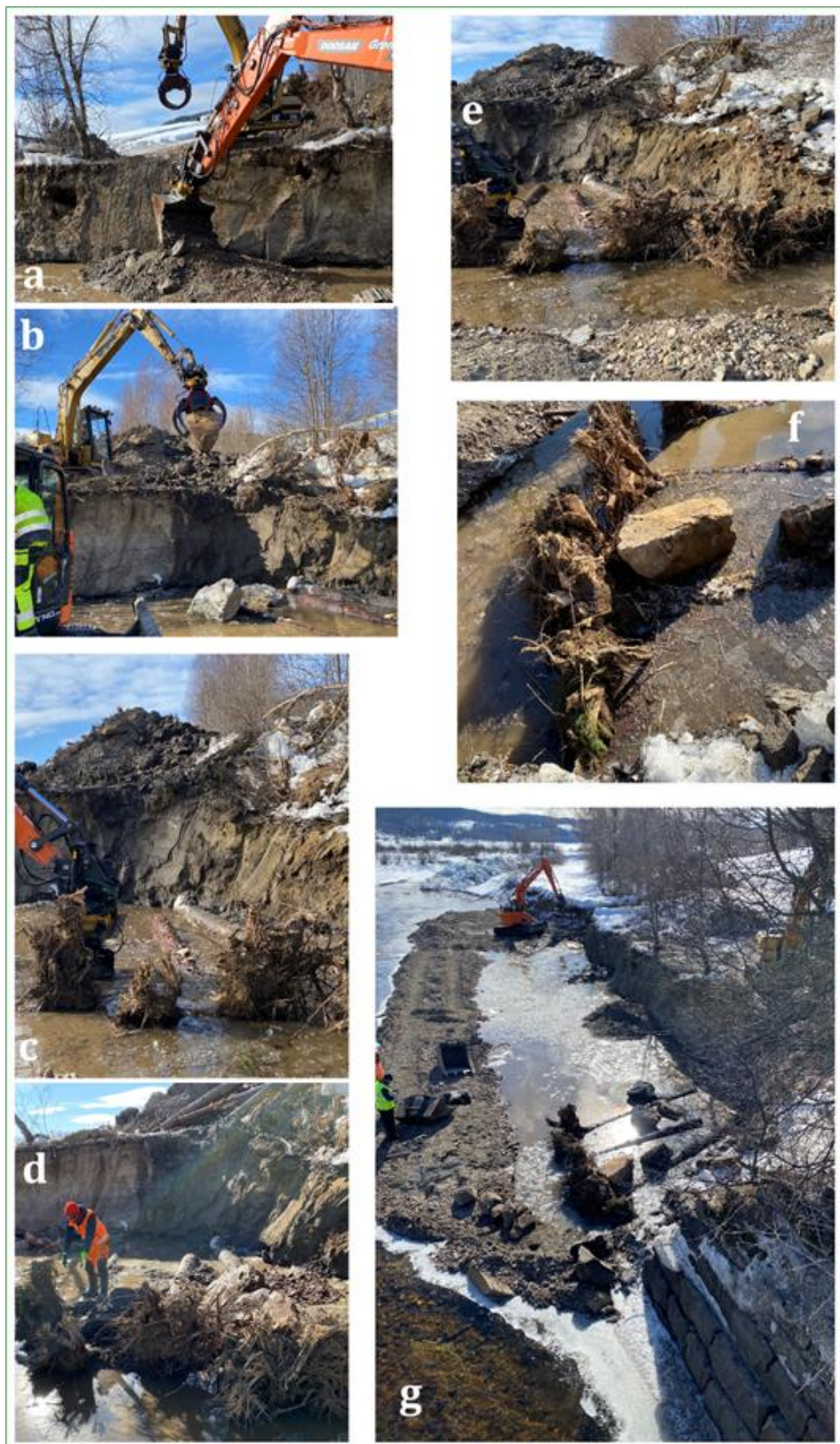
Figur 6 viser bilder fra første dag med nedlegging av rotstokker. Bilde a viser de to gravemaskinene, b viser nedleggelse av stein på de tre første trærne, c, d, e viser nedleggelse av de tre første trærne. F viser plassering av stor stein og g viser et oversiktsbilde hvor det er mulig å også se passasjen som ble laget for tilgang til elva, mannen på bilde er Sam Hesling fra McGowan Ltd (Foto Anja C. Winger)
