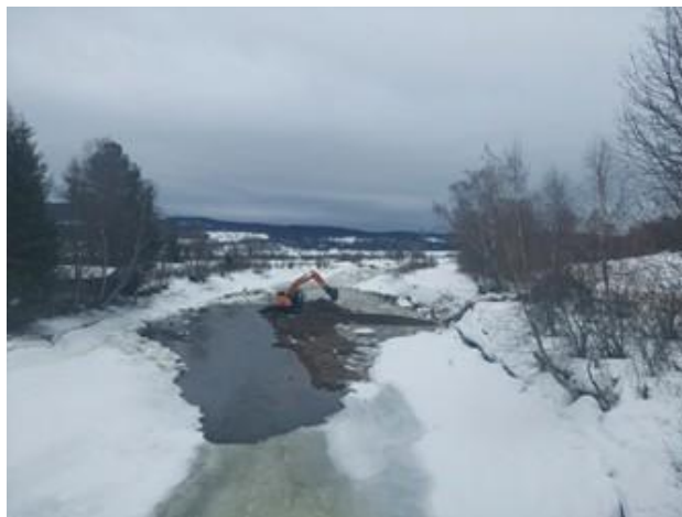
Figur 5. 21. mars 2023 var arbeidet i gang. Det måtte fjernes en god del is. Vannstanden var på dette tidspunktet ca. 172,7 moh. og graveren er i gang med å etablere en molo (Foto Dominika Krzeminska)
