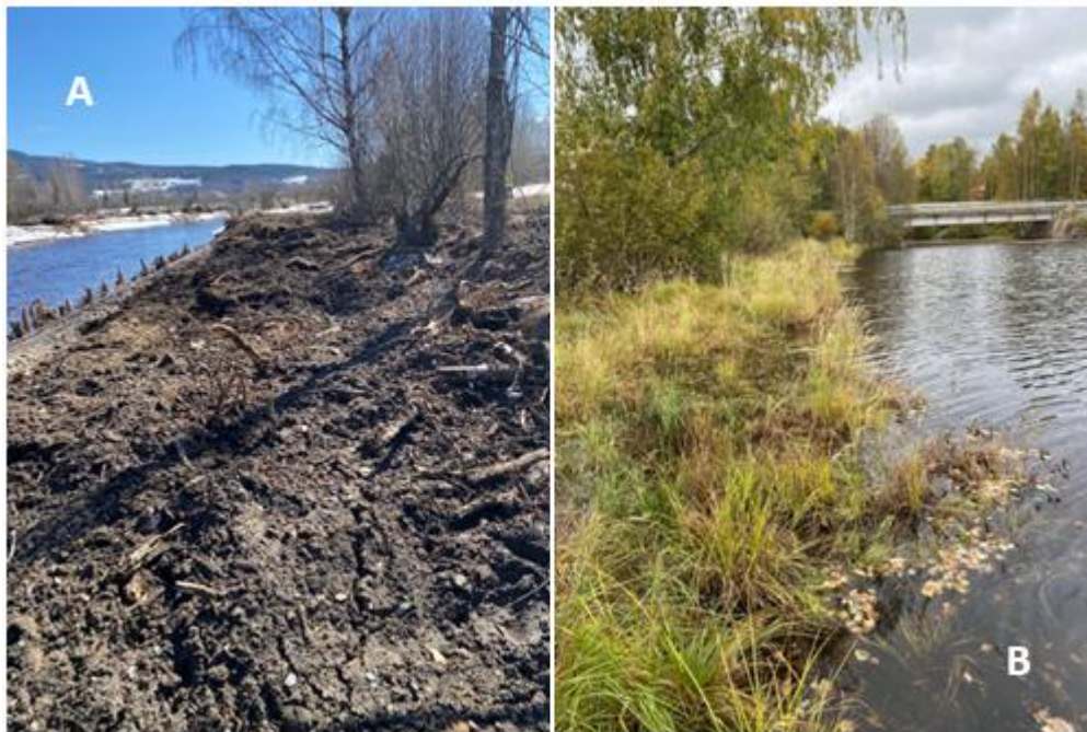
Figur 17. Bilde A viser tilstøtende kantsone og deler av sikringen den 19. april 2023, like etter at anleggsarbeidene var ferdig, og bilde B viser området fra motsatt side den 29. september 2025. Bildene illustrer forskjellen i vannstand og hvor høy vannstand det var på dagen tilveksten ble kartlagt (B). Tilveksten består hovedsakelig av grasarter (se Tabell 2) (Foto: Dominika Krzeminska og Anja C. Winger)
